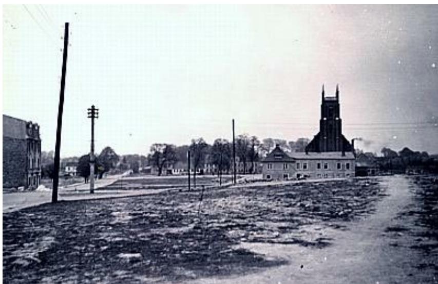
▲ So abgeräumt war's Woldenberg Ende Juni 1945 noch nicht, als die zurückgebliebenen Deutschen ganz schnell 'abreisen' mußten. Da standen noch die vielen Ruinen im Zentrum der Kleinstadt. Dieses Foto entstand erst um 1955. Der Trampelpfad rechts ist die frühere Schulstraße. (Repro: 2011 – khd)
